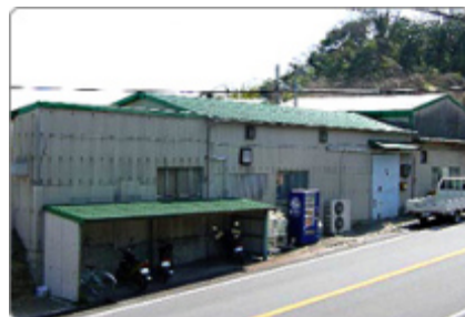
本社(第一工場)
